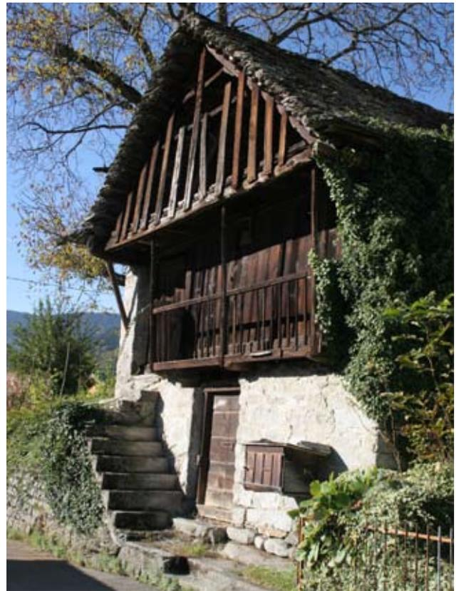
Pioda, q. 767, edificio di servizio, il primo piano è dotato di un balcone per essiccare vari prodotti. Pianale, mensole di sostegno e ringhiera sono in legno. Alcuni elementi verticali fissano la ringhiera allo sporto del tetto.
