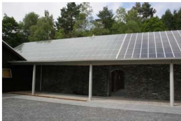
CAT, Centre for alternative technologies, Machynlleth, Powy, (UK) viste dall'interno e dall'esterno di una copertura di cui una falda è interamente realizzata in pannelli fotovoltaici.
