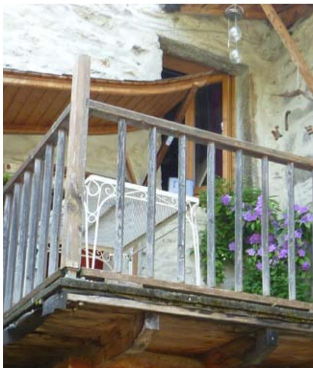
Viganella, esempio di parapetto di nuova realizzazione in legno, rielaborazione del disegno tradizionale.
