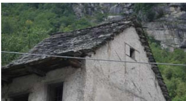
Cadarese, q. 749, edificio a residenza, particolare del tamponamento del timpano di cui si intravede la struttura lignea.
