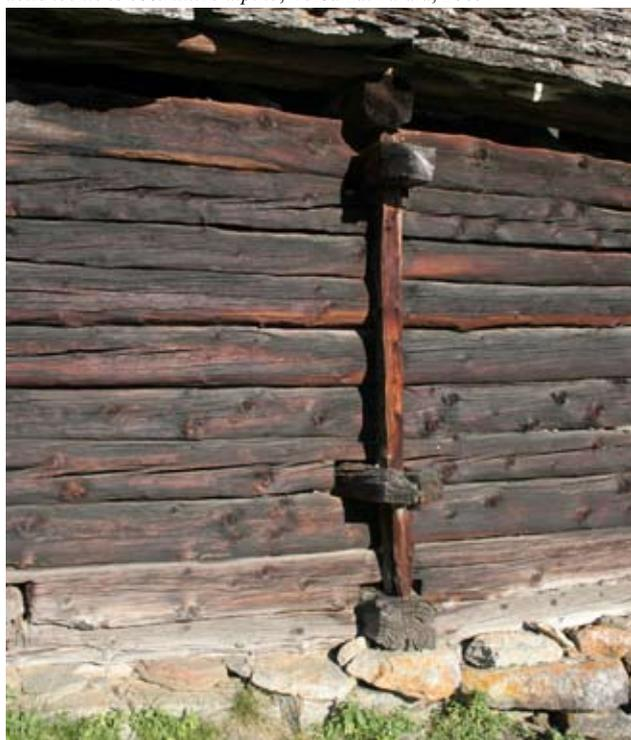
Ausone, *Opso*, q. 1320, elemento verticale posto per impedire la rotazione delle travi su se stesse.
