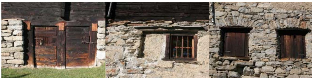
Ausone, *Opso*, q. 1454, particolare della porta di una cantina con architrave e montanti in legno, il serramento è realizzato con tavole orizzontali inchiodate a tavole verticali poste sul lato interno.
