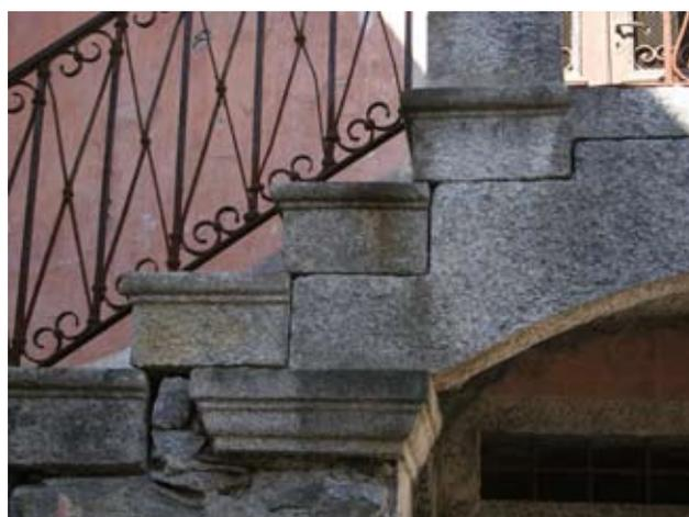
Pioda, q. 767, scala in pietra di un edificio ottocentesco, con dettagli realizzati con grande precisione: i gradini sono costituiti da un unico blocco in pietra lavorata e si appoggiano l'un l'altro per pochi centimetri. I gradini si incastrano perfettamente con l'arco a sostegno del pianerottolo e sono sostenuti da una trave in pietra.
