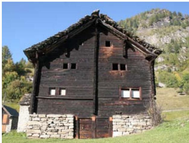
Ausone, *Opso*, q. 1454, casa tipo "del Gottardo", in facciata si vedono le teste delle travi che costituiscono un setto interno centrale.
