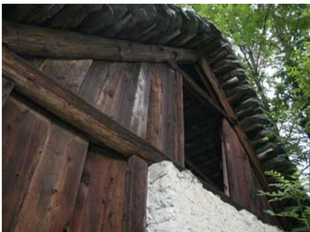
Cadarese, q. 749, edificio a servizio, particolare del tamponamento del timpano ad assi verticali incastrate alle estremità.
