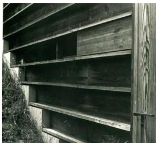
*in senso orario*: edificio collocato su versante; la porzione originale e ampliamento si affaccia su un piccolo terrazzo; particolare dell'involucro di nuova realizzazione, l'apertura si inserisce fra le tavole orizzontali; dettaglio del giunto fra i due volumi.
