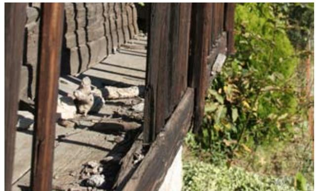
Dettaglio dell'incastro degli elementi verticali della ringhiera con il corrente orizzontale inferiore opportunamente scanalato e a sua volta incastrato alle mensole.
