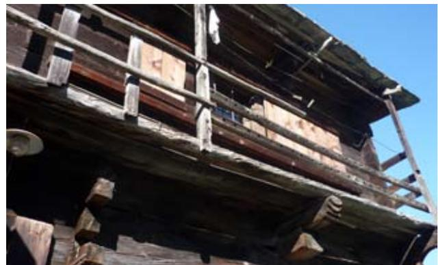
Salecchio Inferiore, Saley, q. 1320, edificio a residenza, con stretto ballatoio in legno. Sia le travi della struttura perimetrale che quelle del solaio sporgono maggiormente per sostenere il pianale.
