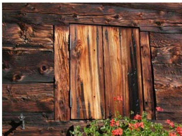
Ausone, *Opso*, q. 1454, edificio a residenza, particolare dell'anta di oscuramento, che, quando chiusa rimane perfettamente a filo della muratura in modo da essere più riparata possibile e ridurre le dispersioni di calore. Ben visibili anche i montanti verticali dell'apertura.
