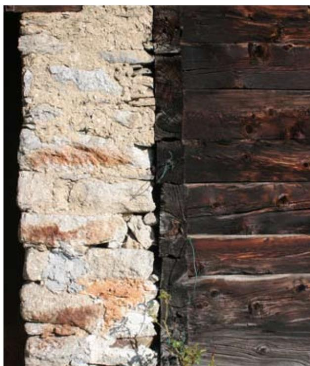
Ausone, *Opso*, q. 1454, particolare del giunto fra la parte in muratura e quella in blockbau.
