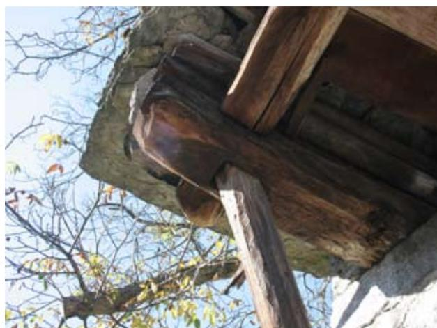
Pioda, q. 767, particolare edificio in fig. , saetta a sostegno del dormiente su cui pesa lo sporto del tetto. A volte il dormiente viene raddoppiato.
