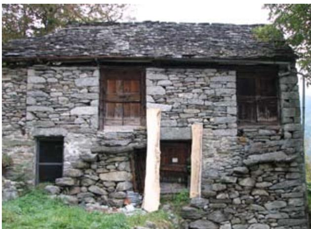
Altoggio, q. 809, edifici di servizio, muro realizzato quasi a secco di varia pezzatura, l'edificio nel tempo è cresciuto in lunghezza, come denotano il vecchio cantonale a cui è adiacente la nuova porzione.
